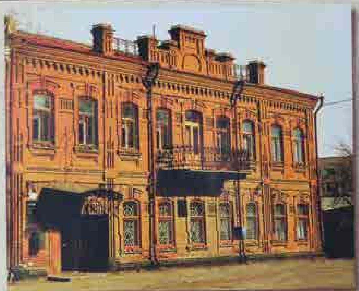
Здание бывшего немецко-польского контора
